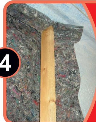
Verkleben Sie die einzelnen Bahnen und die Türe mit Klebeband aneinander.
