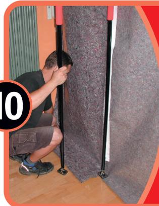
Die anschließende Feinspannung ermöglicht, dass sauber und staubdicht abgeklebt werden kann.
